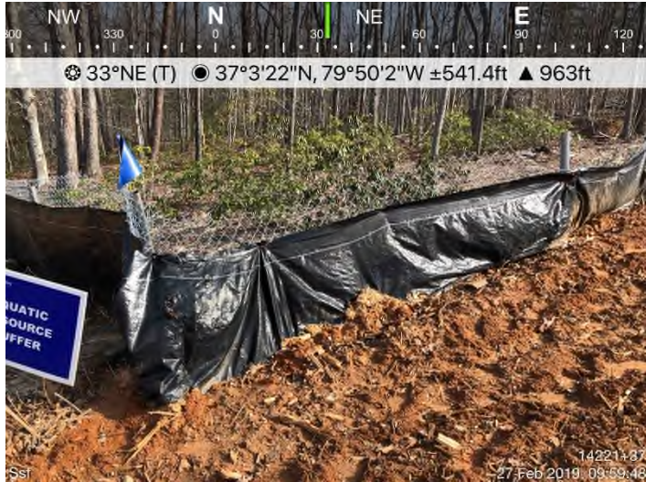
Fig. 7: STA 14221+37 – Maintain SSF.
