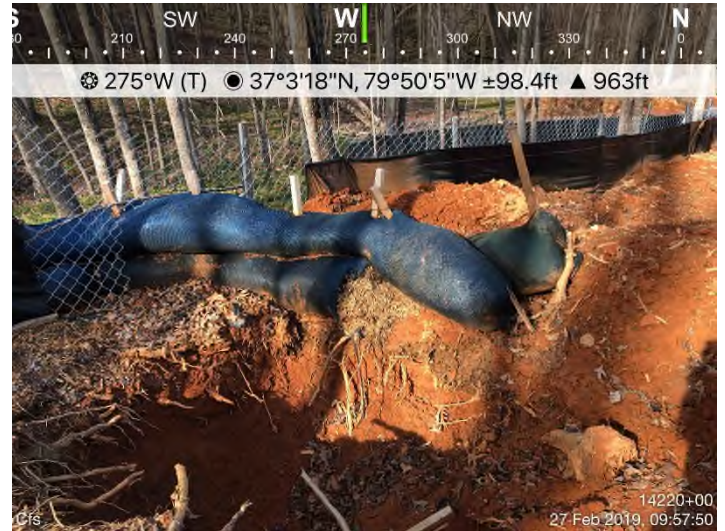
Fig. 8: STA 14226+04 – Sediment off ROW.
