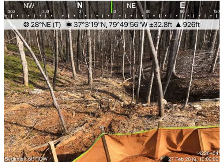
Fig. 8: STA 14226+04 – Sediment off ROW.
