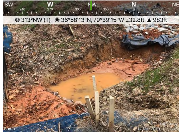
Fig. 12: STA 14879+02 – Maintain/cleanout sump.
