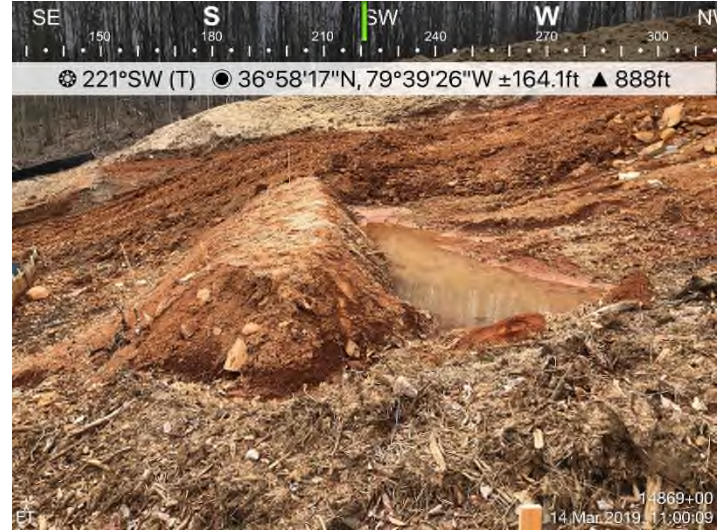
Fig. 12: STA 14879+02 – Maintain/cleanout sump.
