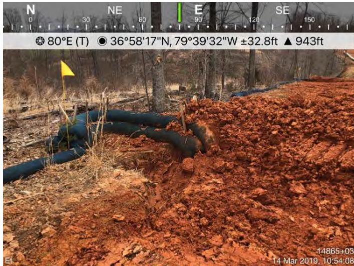
Fig. 11: STA 14876+72 – Maintain/cleanout sump.
