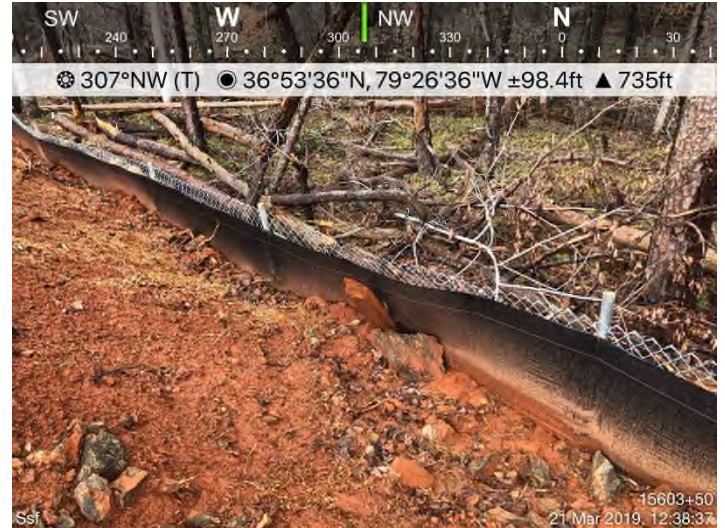
Fig. 4: STA 15603+50 - Repair SSF.
