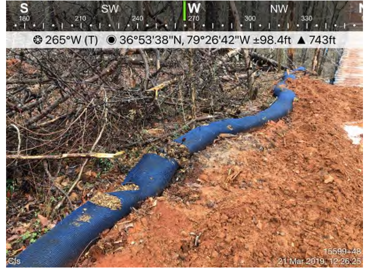
Fig. 4: STA 15603+50 - Repair SSF.
