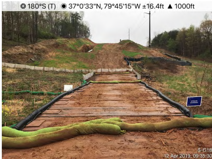
Fig. 3: STA 14533+00 – Waterbar not per spec.
