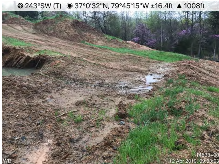
Fig. 3: STA 14533+00 – Waterbar not per spec.
