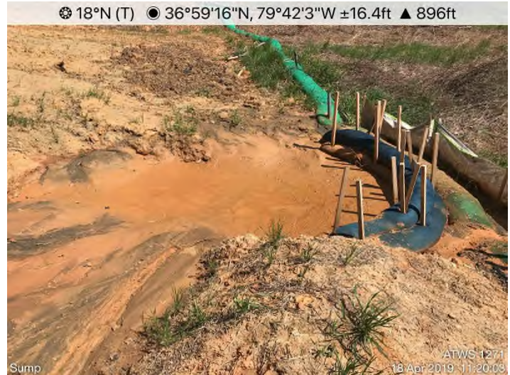
Fig. 4: STA 14722+11 – Clean out sump in ATWS 1279.
