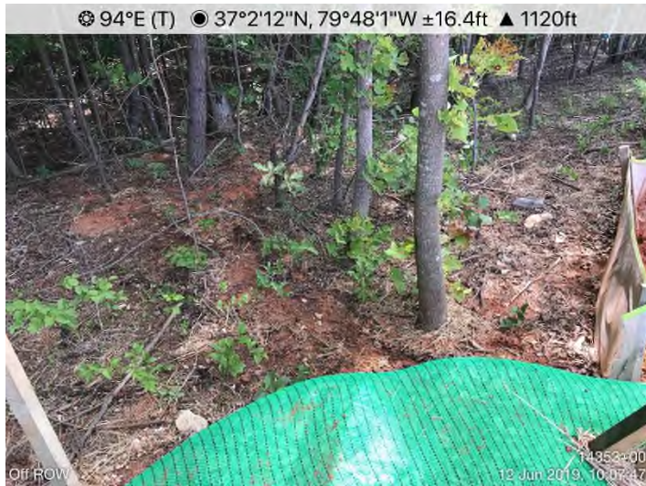
Fig. 3: STA 14351+00 – Sediment off ROW.
