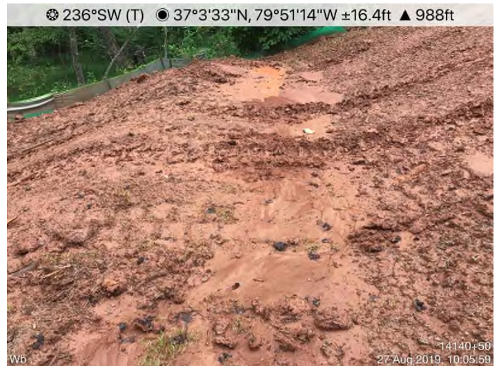
Fig. 4: STA 14179+00 – Sediment off ROW.
