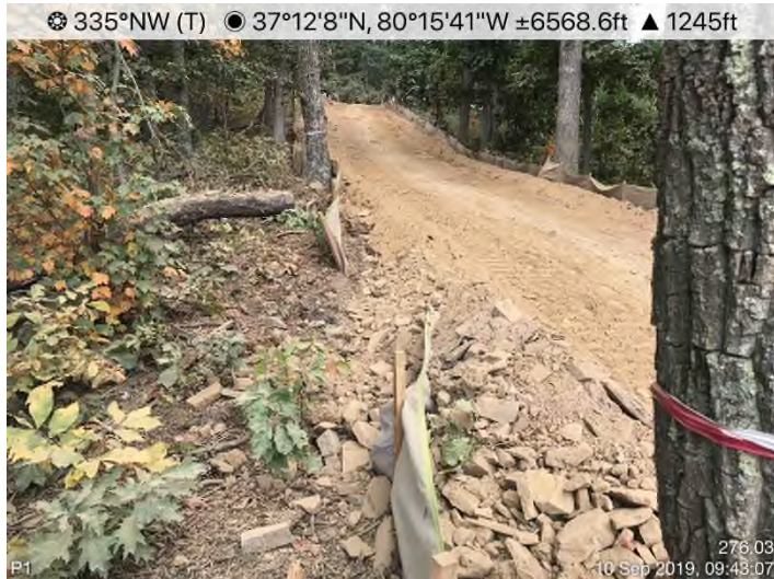
Fig. 3: STA 12360+91 – Stabilize fill slopes.
