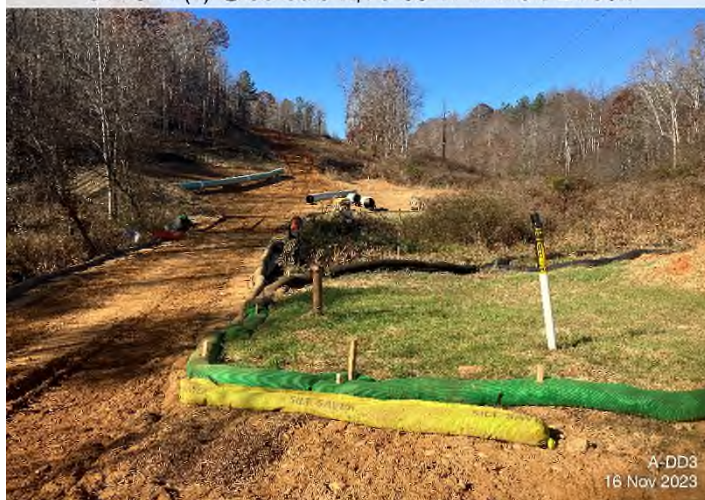
Figure 4: STA 14183+72 – Install temp. WB per specifications.
